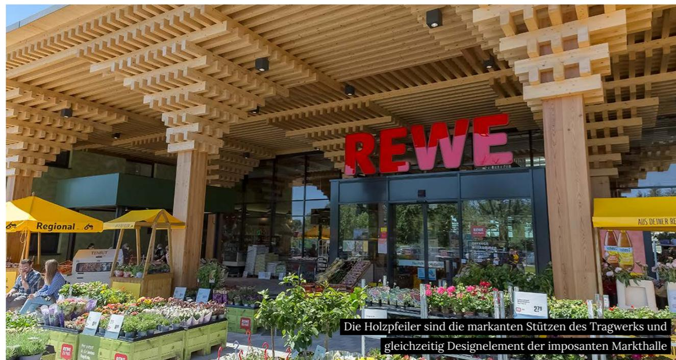
Die Holzpfiler sind die markanten Stützen des Tragwerks und gleichzeitig Designelement der imposanten Markthalle
